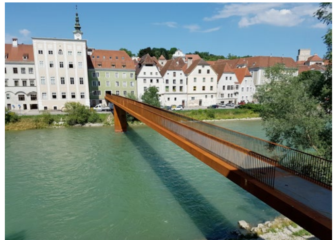
Steg über die Enns mit zwei Tilgern nach Fertigstellung
