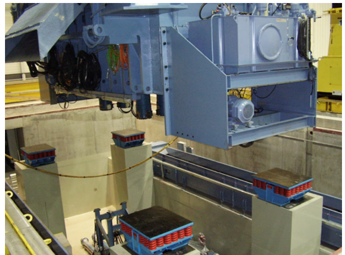
Absenkung des Pressenunterteils auf die KTI Federlager
